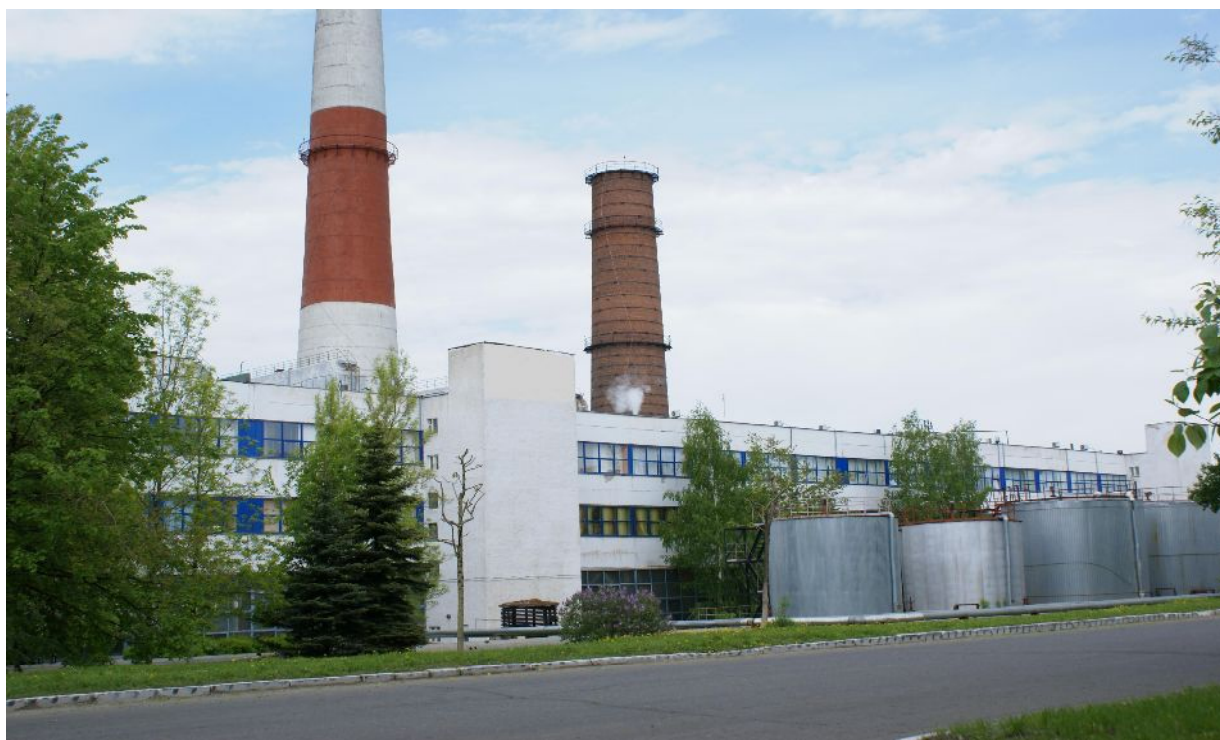
Рис.4 Котельная ОАО «ИжАвто»
