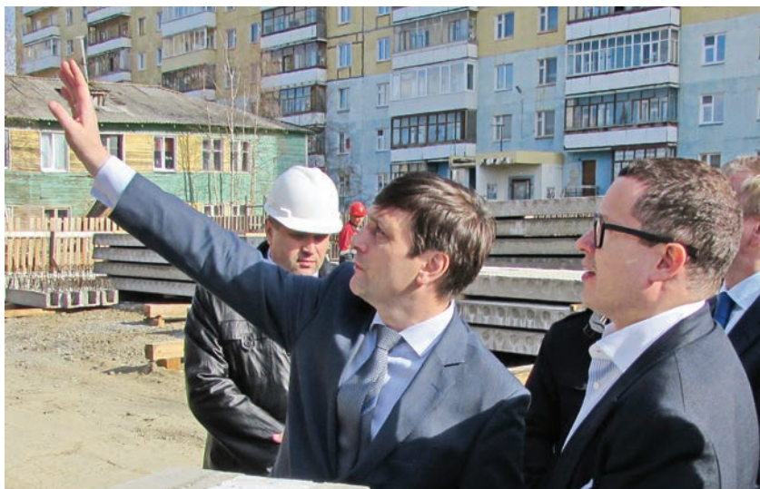
Строительство общежития на 340 мест для персонала алмазной Компании в г. Мирном (ввод в эксплуатацию 2016 год).
