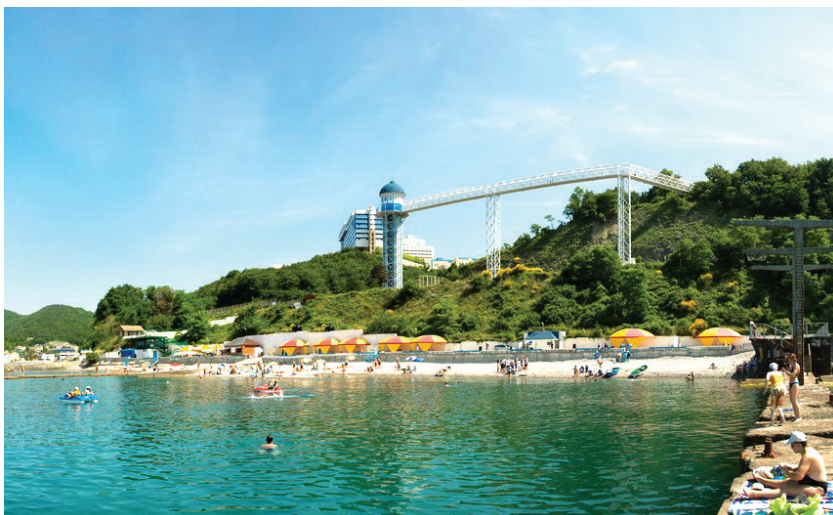
Оздоровительный комплекс «Прометей» для трудящихся и ветеранов Компании в п. Небуг, Краснодарского края
